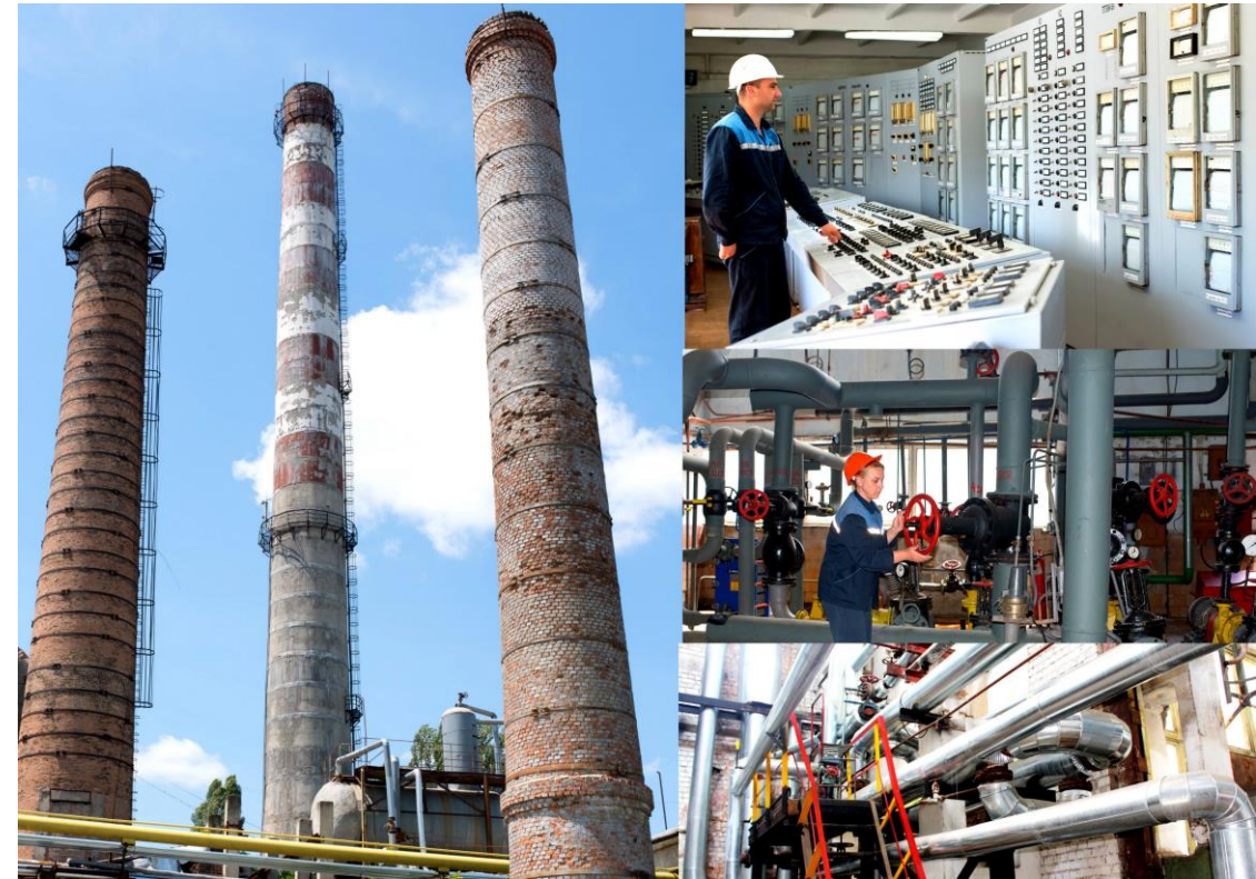
CT Vest, CT Sud și CT Suburbane
